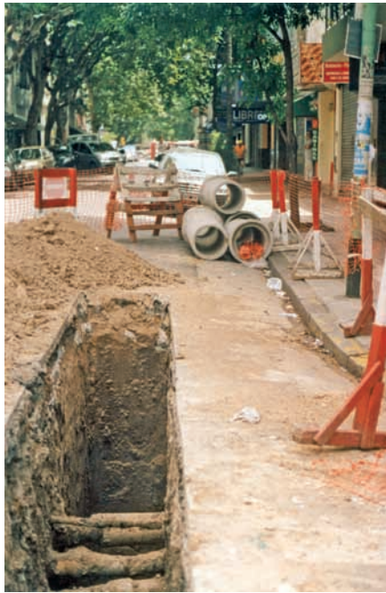
Suelo urbano fuertemente modificado. El suelo está impermeabilizado por el asfalto, fue decapitado en su parte superior y se encuentra sumamente disturbado por los trabajos de instalación de ductos.
